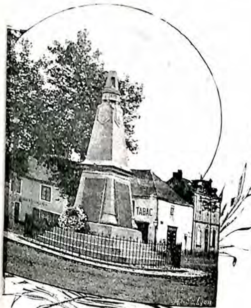
LE MANS. Monument du Pontlieue
